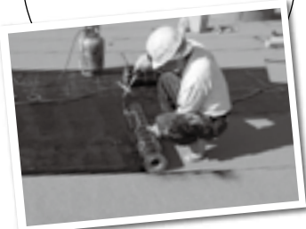
この防水シートを屋根に貼っていきます
